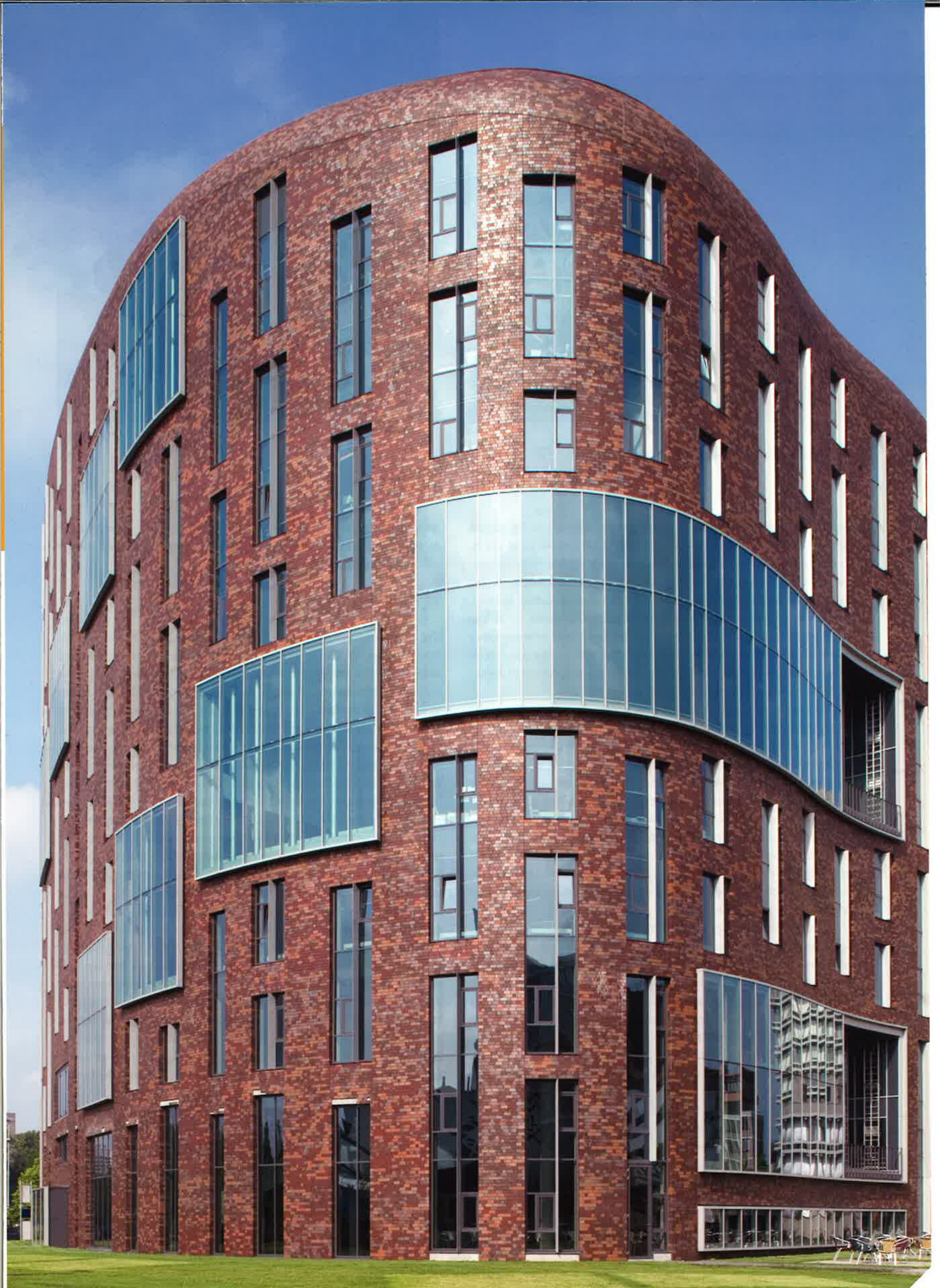
OZW VII, Opleidingsinstituut voor Zorg en Welzijn, Amsterdam (Jeanne Dekkers Architectuur, Delft) Foto Luuk Kramer
