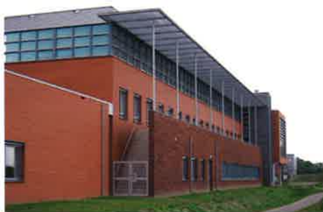
▲ Schoon metselwerk door een juiste detaillering
