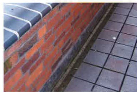
▲ De loodslabbe dekt de naad tussen dakbedekking en wand af.
